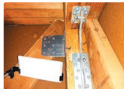
▼ 柱の金物補強
