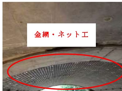
写真2.3 金網・ネット工の事例
