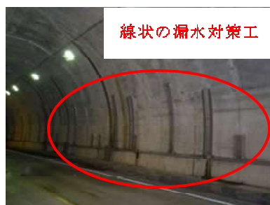
写真2.4 線状の漏水対策工の事例
