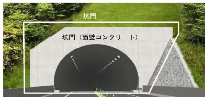
図4.1 トンネル本体工点検箇所
