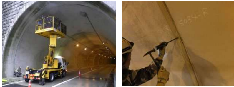
写真4.1 定期点検状況
