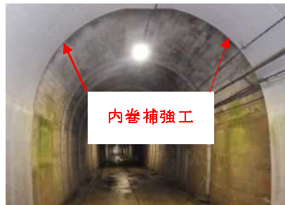
写真2.2 内巻補強工の事例
